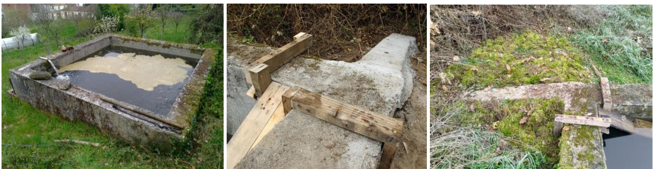
18. (Izq.) Alberca sin infraestructuras. (Cen.) Rampa en construcción. (Dcha.) Rampa finalizada e integrada en el medio natural.
